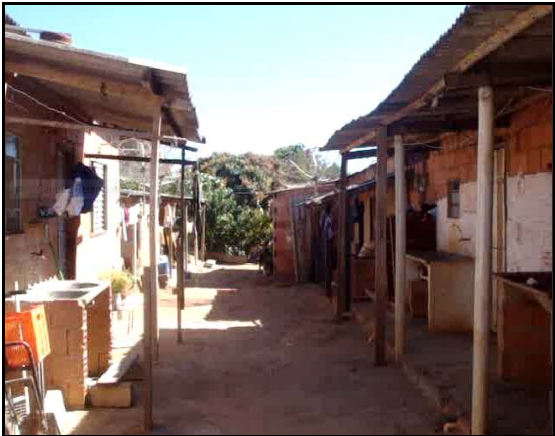
Foto 01- Barracos, em Domiciano Ribeiro destinados a aluguel para trabalhadores rurais. Neste lote havia 10 moradias. Foto da autora, 2011.
